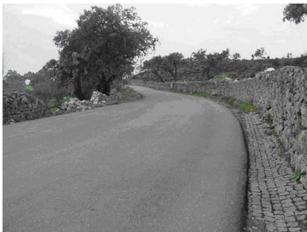
Ilustración 2. Pavimentación de los caminos de Freguesía de Idanha-a-Nova (Proyecto CMAEBAH / SP4.P1)
